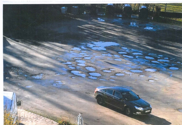
Place de Marchal avant les travaux
